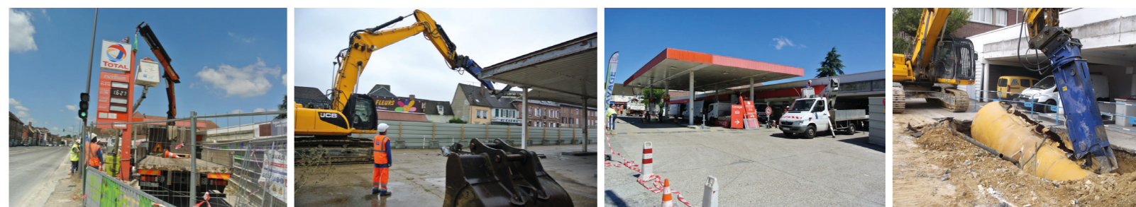
Démantèlement d'une station-service TOTAL à BEAUVAIS
