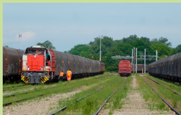
Géotextiles sur piste ©DR
