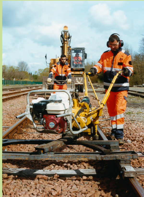
Remplacement de traverses avec une tirrefonneuse ©Ronan Guillou
