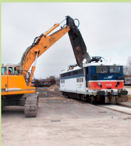
Locomotive électrique BB17099 en cours de démantèlement ©DR
