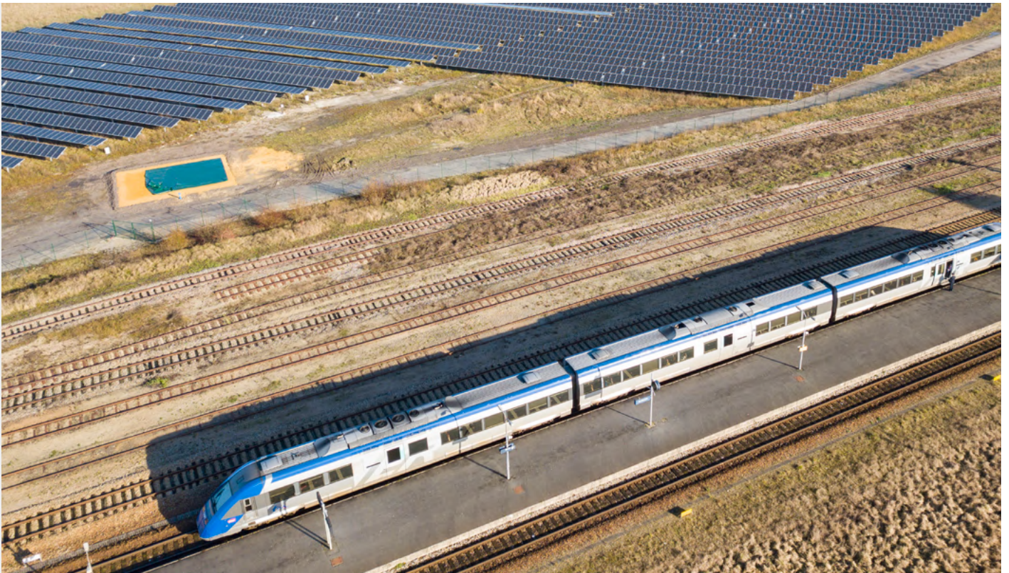
Centrale solaire de Surdon, mise à disposition par SNCF d'une ancienne friche industrielle ©Charly Lataste
