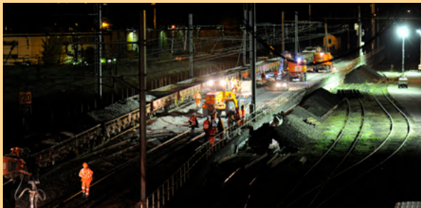
Renouvellement de voie et ballast ©A. Montigny
