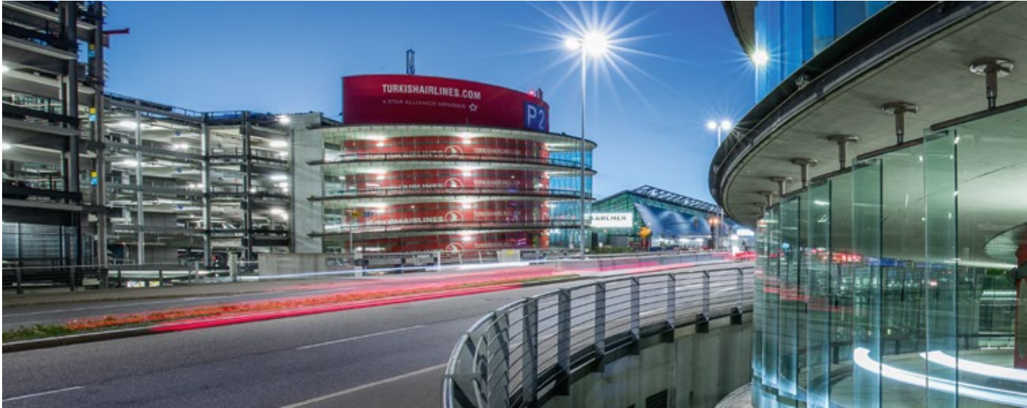
Die Passagiere des Stuttgarter Flughafens kommen mit Bus, Bahn und Pkw. Um dem steigenden Verkehrsaufkommen gerecht zu werden, vergrößert die FSG das Parkhaus P2 im Westen der Airport City. 1.200 neue Stellplätze entstehen dort.
