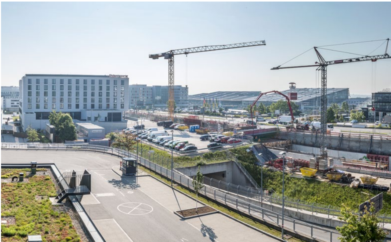
Kräne und Bagger im Einsatz in der Stuttgart Airport City: Hier entstehen das zweite Mövenpick-Hotel auf dem Campus sowie eine neue Haltestelle für die Stadtbahn U6.
