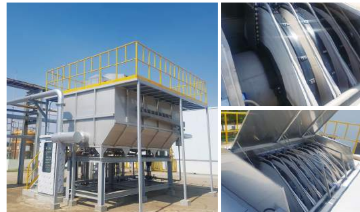
아산공장 섬유디스크필터 설치
