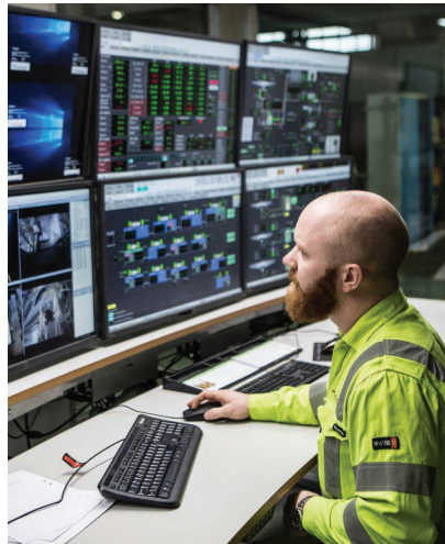
Zinkgruvan – New Control Room
