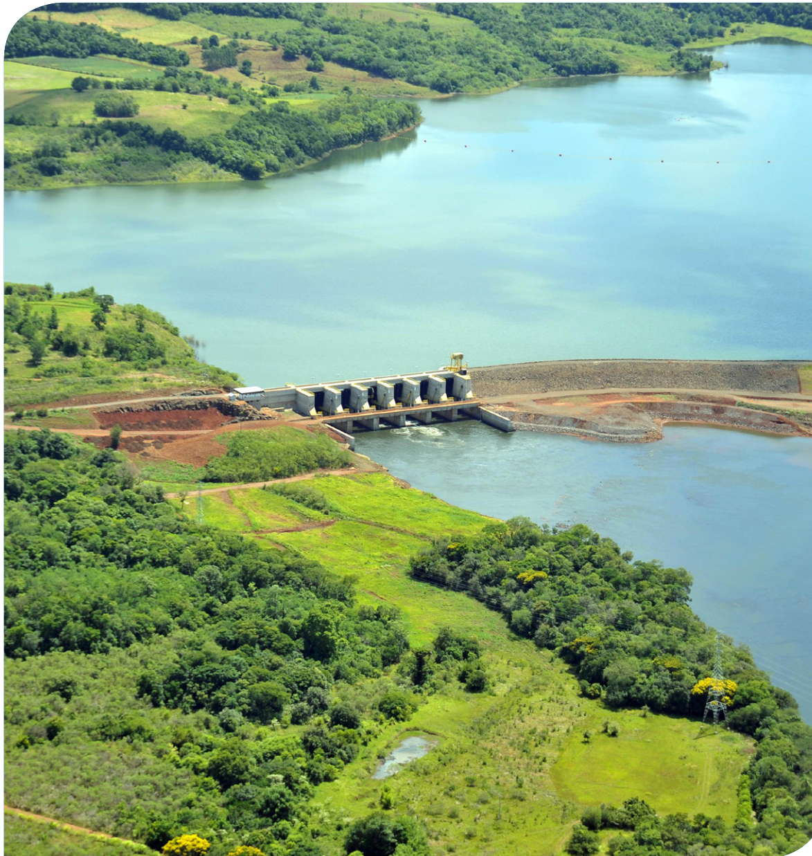
HPP Passo São João. Eletrobras Eletrosul collection
