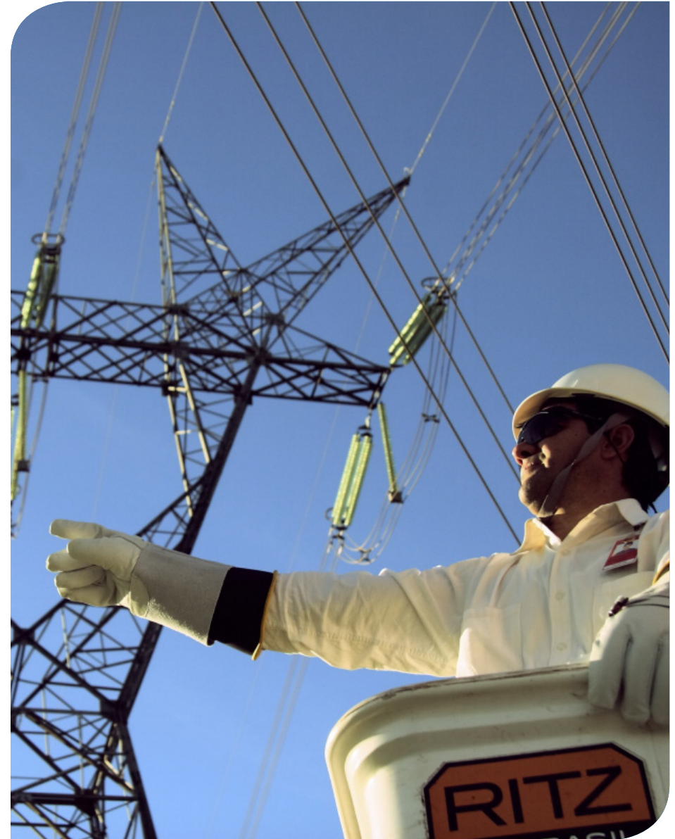
Itaipu Binacional substation. Itaipu Binacional/Alexandre Marchetti collection
