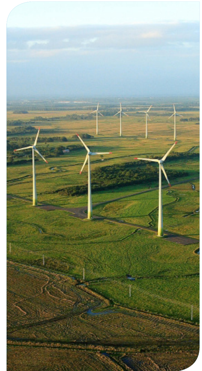
Osório wind farm. Eletrobras Eletrosul collection
