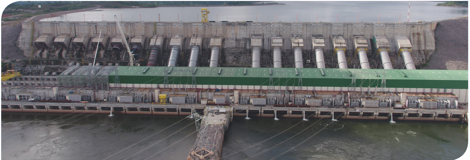
Main power house HPP Belo Monte. Norte Energia collection
