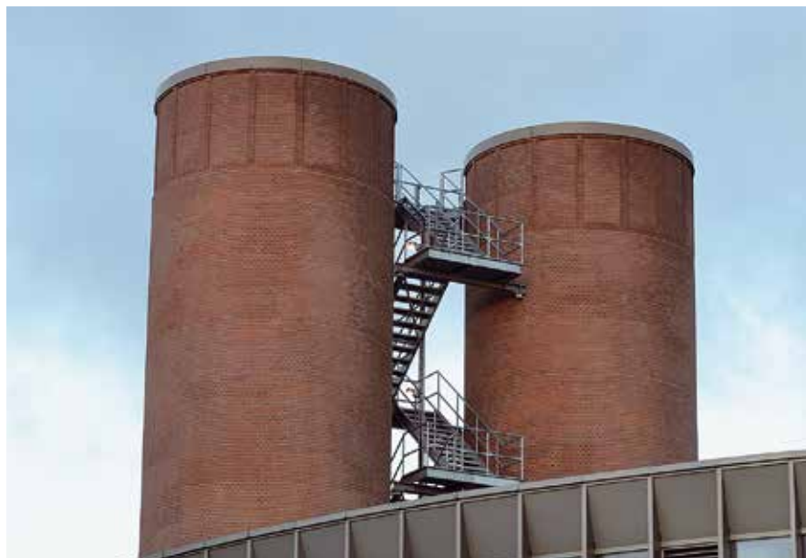
Den nybyggede Kløvermarkens Pumpestation på Amager har to markante tryktårne. Pumpestationen sender byens spildevand videre til renseanlægget på Lynetten.
