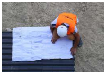
RÉALISATION D'UN CHANTIER VERT
