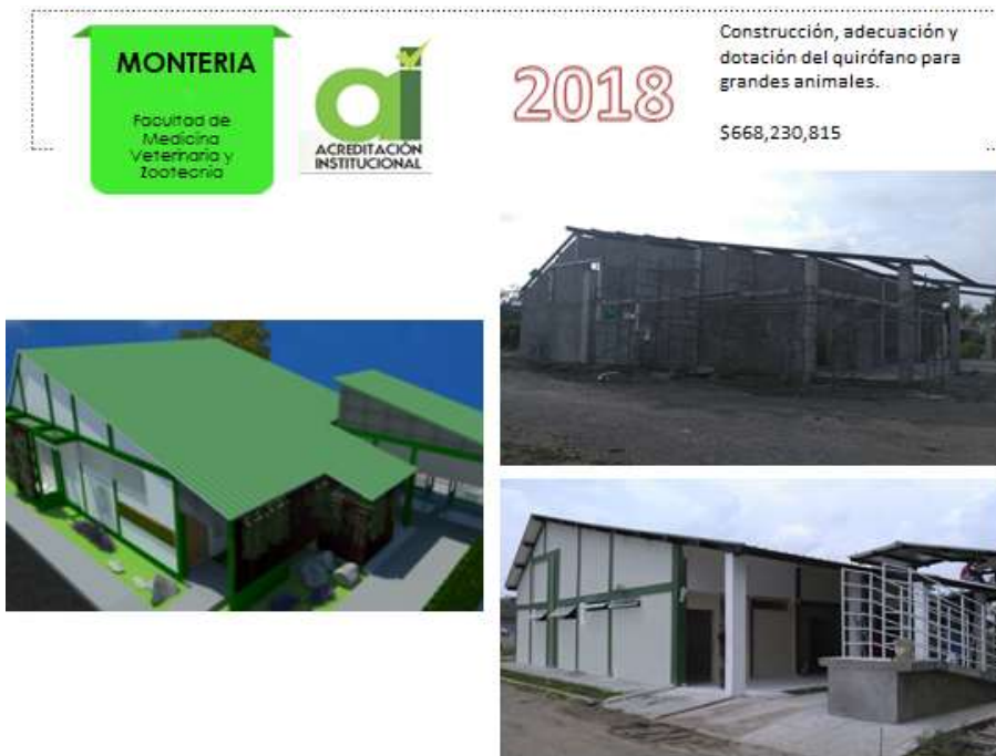
Ilustración 41. Construcción, adecuación y dotación del quirófano para grandes animales
