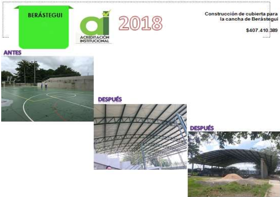
Ilustración 40. Construcción de cubierta para la cancha de Berastegui
