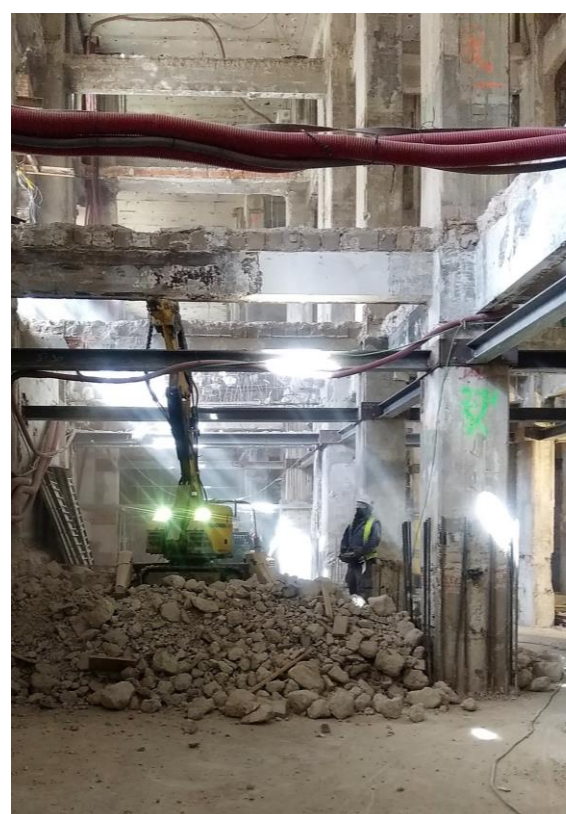
Rehabilitación Edificio España
