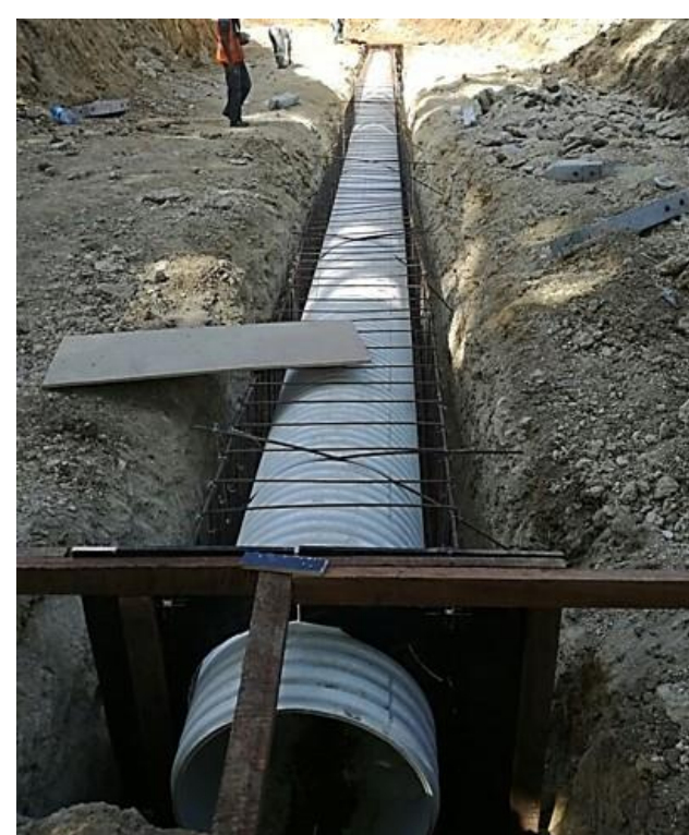
Alcantarillado de San Miguelito. (Panamá)
