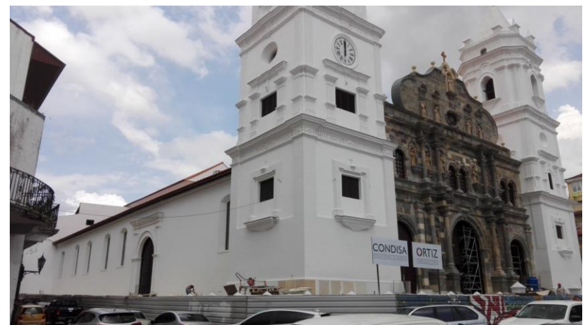
Restauración Catedral Sta. María La Antigua (Ciudad de Panamá)
