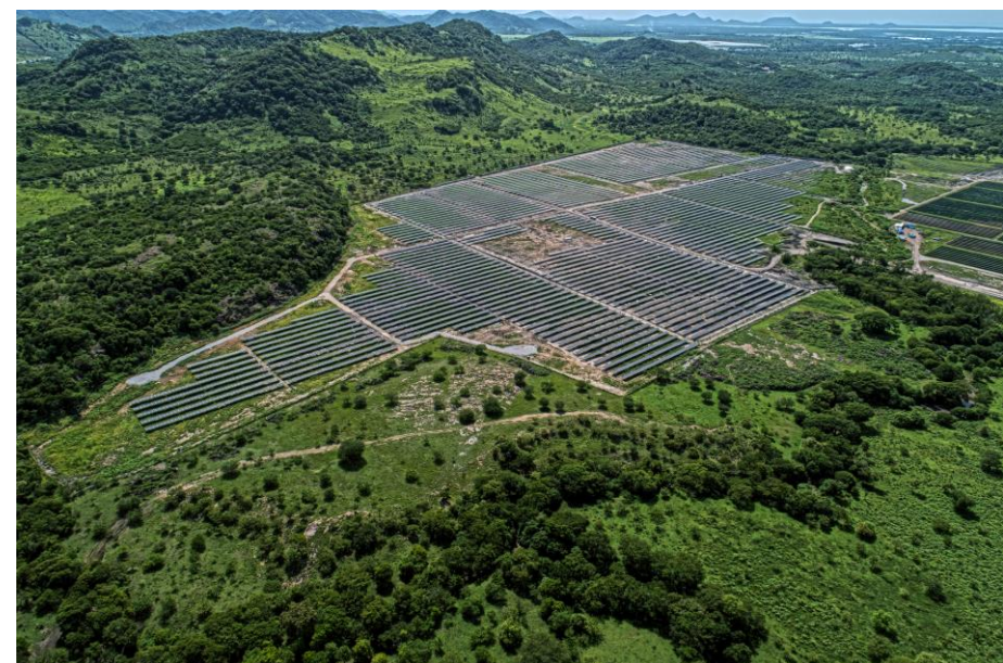
Planta Solar Fotovoltaica en Aguascalientes (México)
