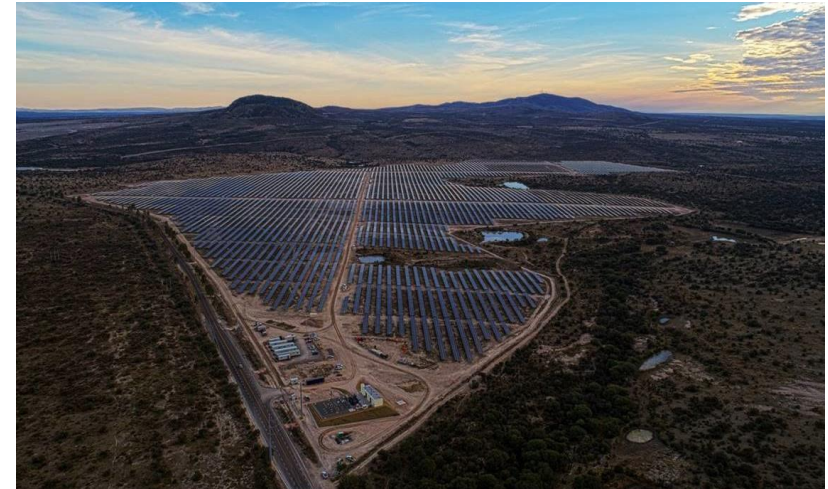
Planta fotovoltaica México
