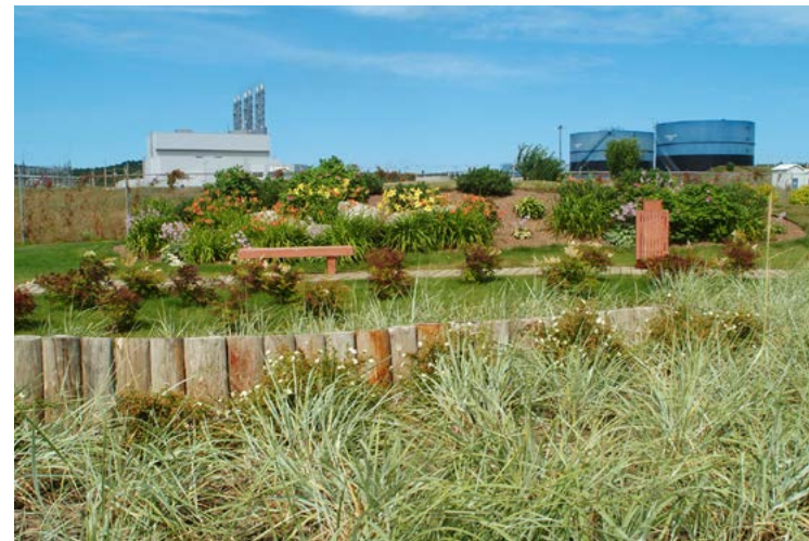
La centrale des Îles-de-la-Madeleine, la plus grande centrale thermique à moteur diesel du Québec. La transition énergétique aux îles entraînera une réduction considérable des émissions de GES.
