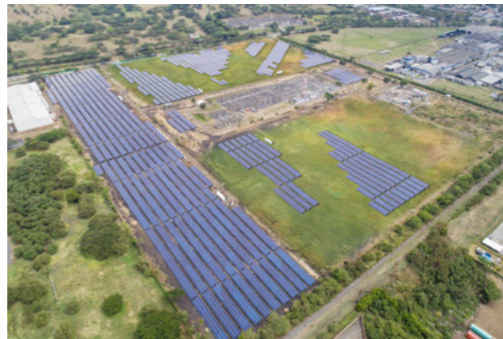
Granja solar Celsia, que abastece de energía fotovoltaica a Postobón Yumbo.
