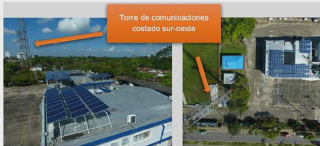
Ubicación de torre de comunicaciones como aporte de sombra temporal
