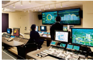
地域のエネルギーを見守る「柏の葉スマートセンター」
