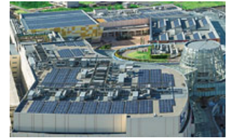
「ららぽーと柏の葉」屋上の太陽光パネル
