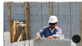
BOXXER Ledwith de EPB en obra de hormigón (Buenos)
