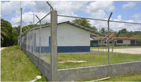
Construcción de muro perimetral en escuela El Tamarindo.
