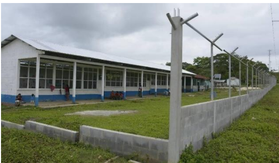
Construcción de muro perimetral en escuela El Tucán.
