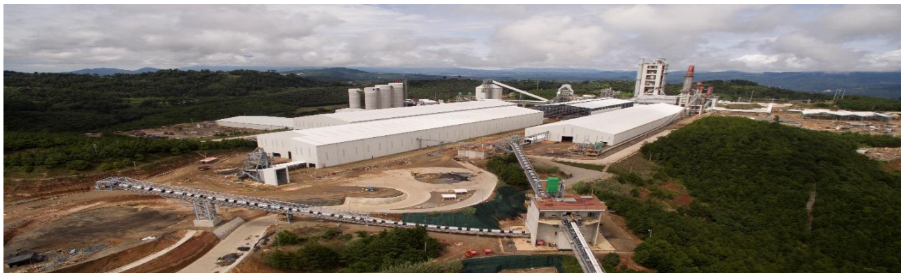
Planta San Gabriel, en proceso final de construcción, ubicada en San Juan Sacatepéquez, Guatemala.
