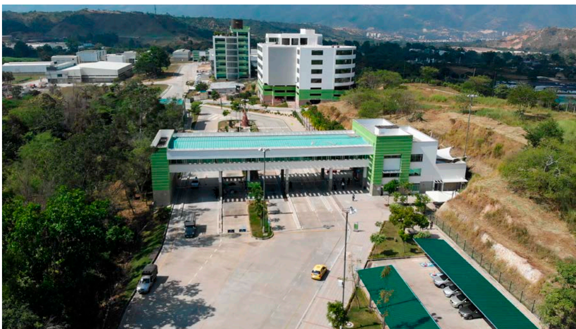
Foto 1. Construcciones en ZFS 2018
