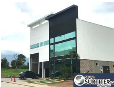
Foto 2. Construcción Grupo Surtitex
