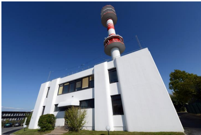
Datacenter TDF de Rennes
