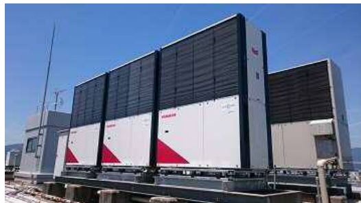
更新した空調機（室外機）
