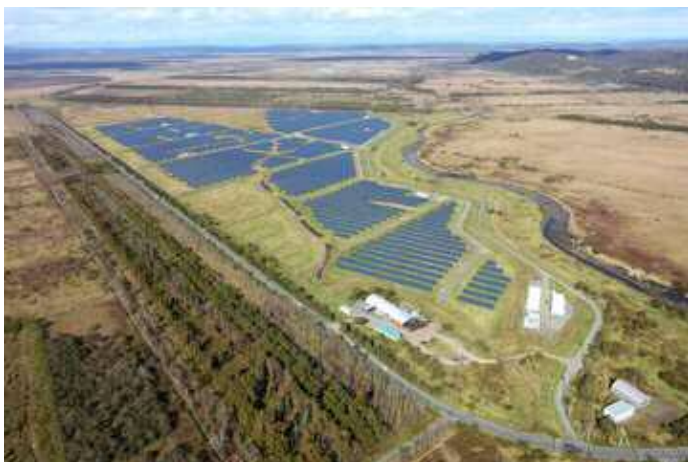
釧路町トリトウシ原野太陽光発電所全景
