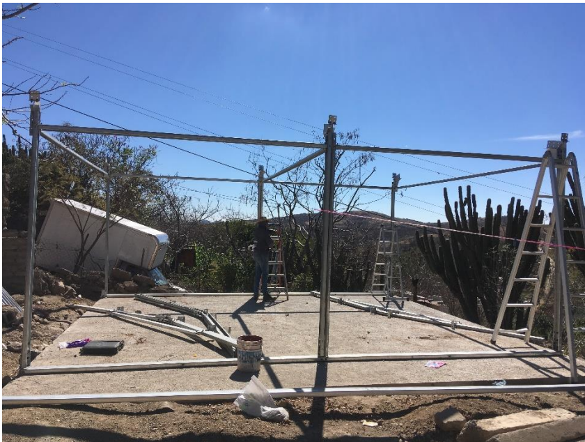
Imagen de la estructura terminada de una de las casas que hemos entregado.
