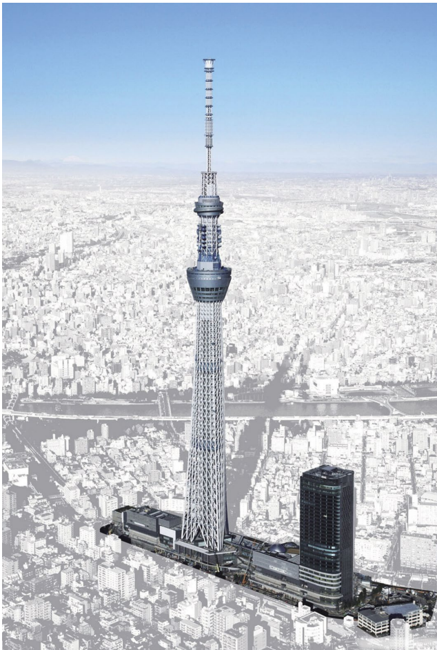
東京スカイツリー®地区 地域冷暖房設備（東京都墨田区）
