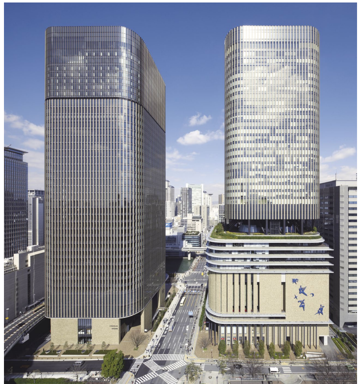
フェスティバルシティ 空調・地域冷暖房設備（大阪府大阪市）
