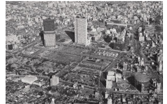
新宿副都心地区 地域冷暖房設備
