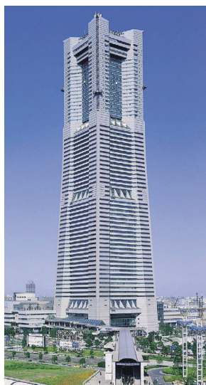
横浜ランドマークタワー 空調設備
