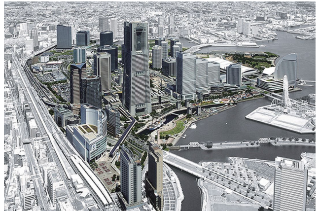
みなとみらい21中央地区 地域冷暖房設備（神奈川県横浜市）
