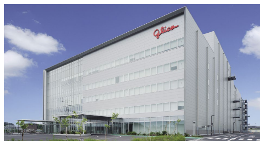
関東グリコ北本ファクトリー 空調・衛生設備(埼玉県北本市)
