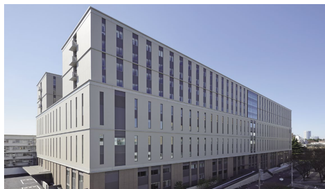
慶應義塾大学病院1号館 空調設備(東京都新宿区)
