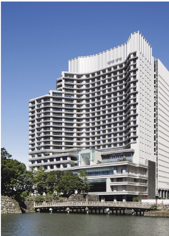
パレスホテル東京・パレスビル 空調設備（東京都千代田区）
