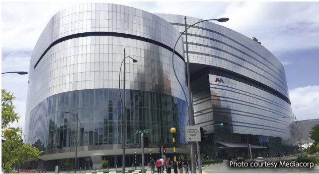
メディアコープ キャンパス 空調換気設備 (シンガポール)
