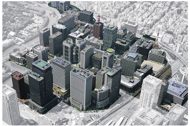
大手町地区・丸の内一丁目地区他 地域冷暖房設備（東京都千代田区）
