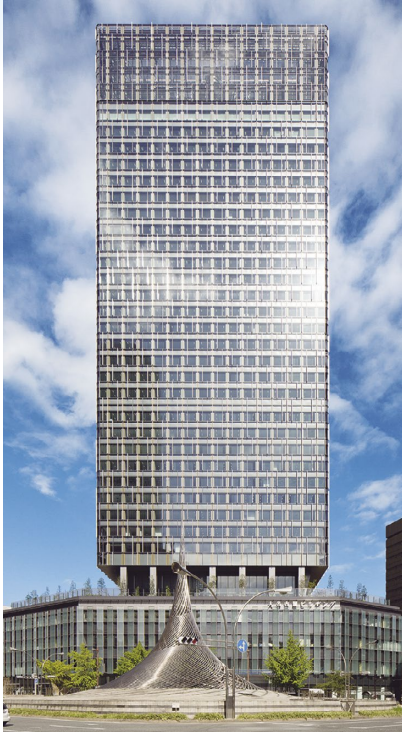
大名古屋ビルヂング 空調設備（愛知県名古屋市）
