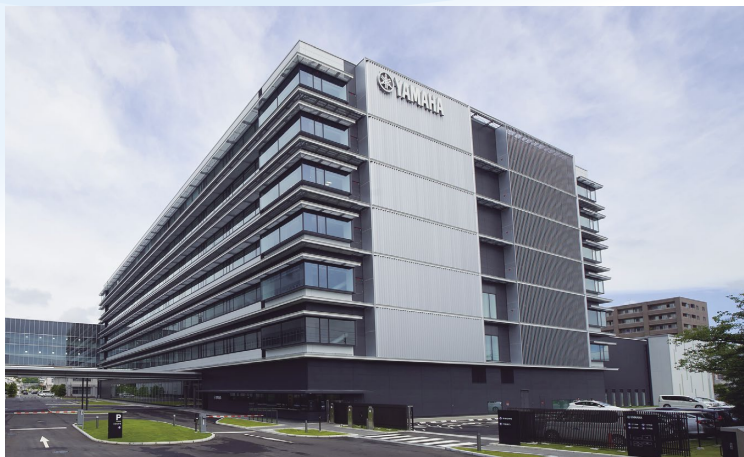
ヤマハ株式会社本社21号館 空調設備(静岡県浜松市)
