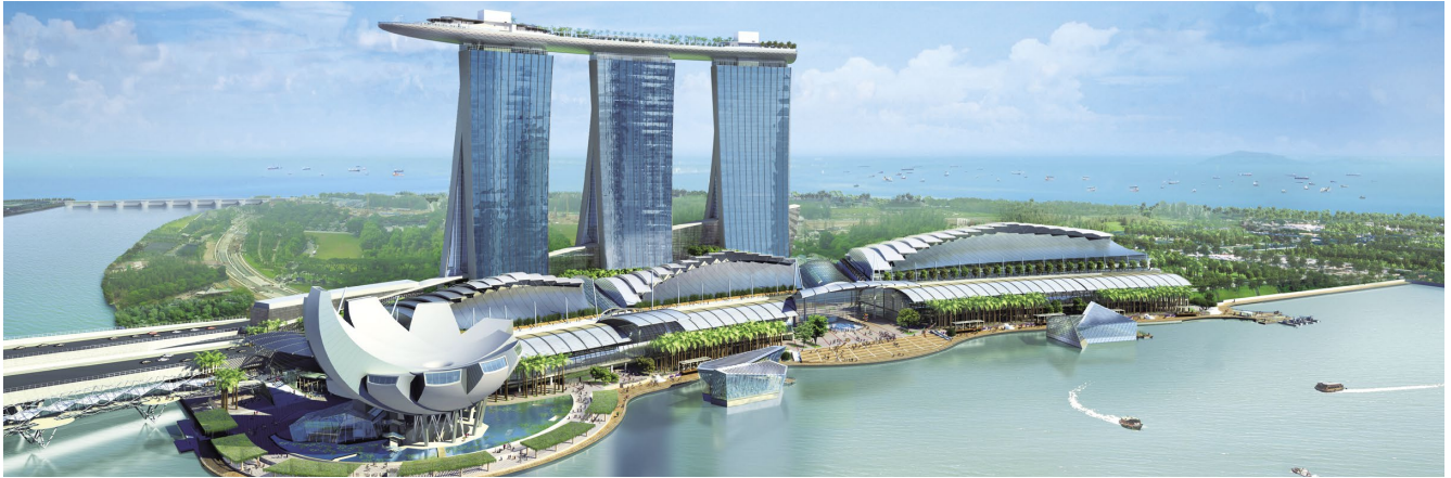
マリーナベイ サンズ複合施設 空調換気設備 (シンガポール)
