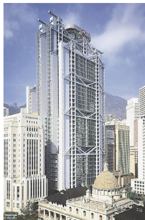
香港上海銀行本店ビル 空調・衛生・電気設備(香港)
