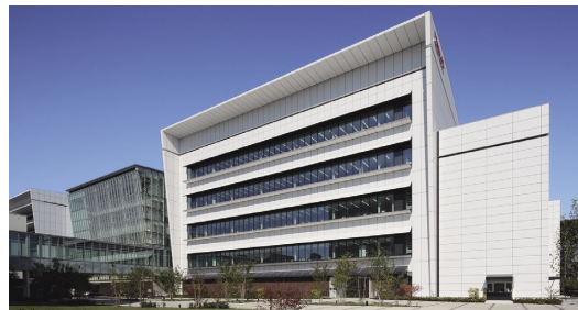
ヤクルト本社中央研究所基礎研究棟 空調設備(東京都国立市)
