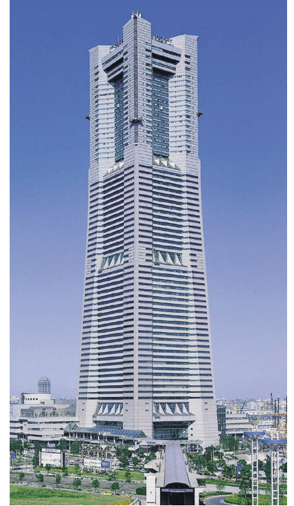
横浜ランドマークタワー 空調設備（神奈川県横浜市）
