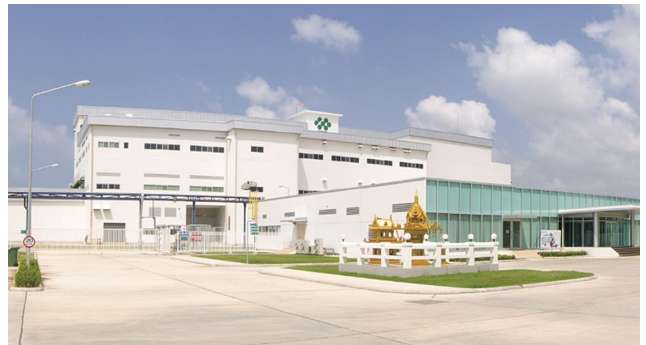
タイ協和バイオテクノロジーズ プラント設備・土木建築(空調・衛生・消火・電気・計装含む) (タイ)
