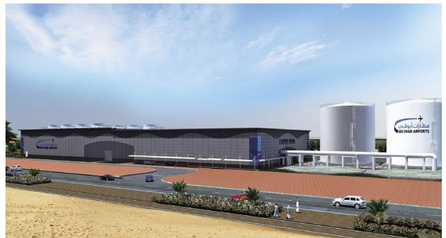
アブダビ国際空港新ターミナル向け地域冷房プラント 地域冷房設備 (アラブ首長国連邦)
