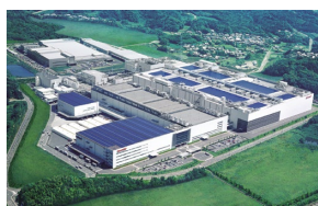
シャープ株式会社亀山工場 空調設備
