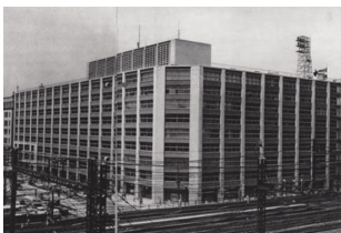
新大手町ビル 冷暖房設備
