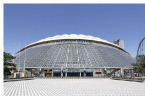
東京ドーム 空調設備
