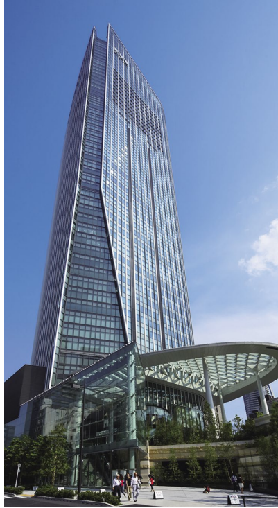
虎ノ門ヒルズ 空調設備（東京都港区）
