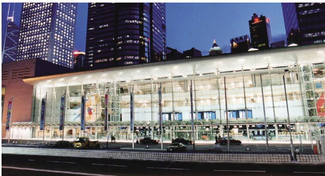
香港MTRC空港線香港駅 空調・衛生・消火・電気設備 (香港)
