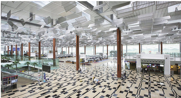
チャンギ国際空港ターミナル3 空調換気設備 (シンガポール) "Courtesy of Civil Aviation Authority of Singapore"
