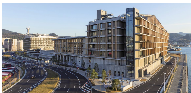
長崎県庁舎 行政棟 空調設備(長崎県長崎市)
