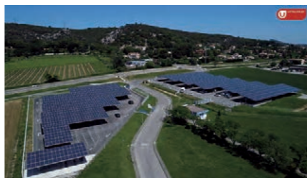
Cevennes工場駐車場に設置された太陽光パネル
