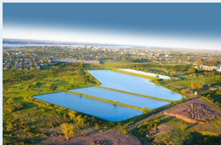
リオグランデ・ド・スル州 下水処理場
