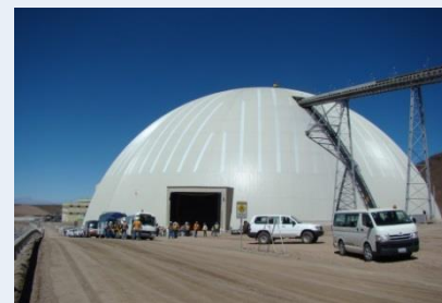
サンクリストバル鉱山の粉塵飛散防止の巨大ドーム
