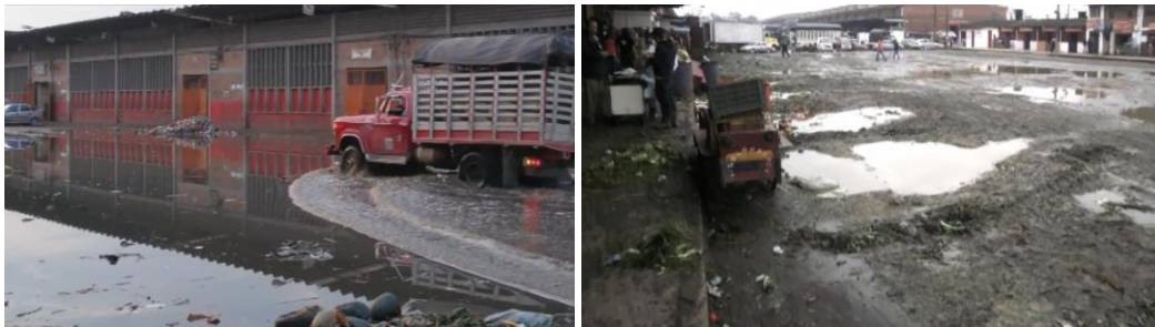
Fuente: Archivo fotografico vias en Corabastos antes del proyecto de infraestructura vial
