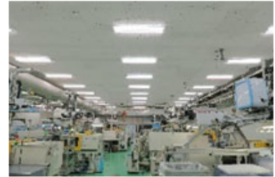
山形カシオ工場のLED照明
