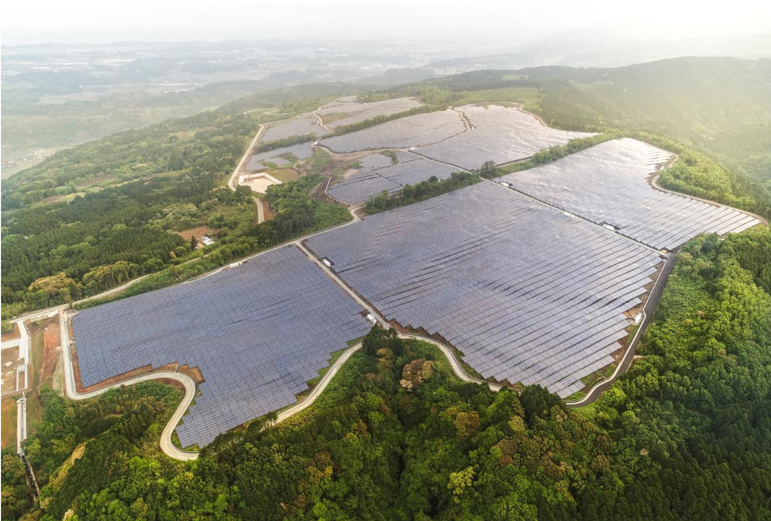
Planta fotovoltaica de Mashiki. Japón 47.67 Mw
