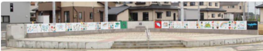
移設により完成した壁面のモニュメント
