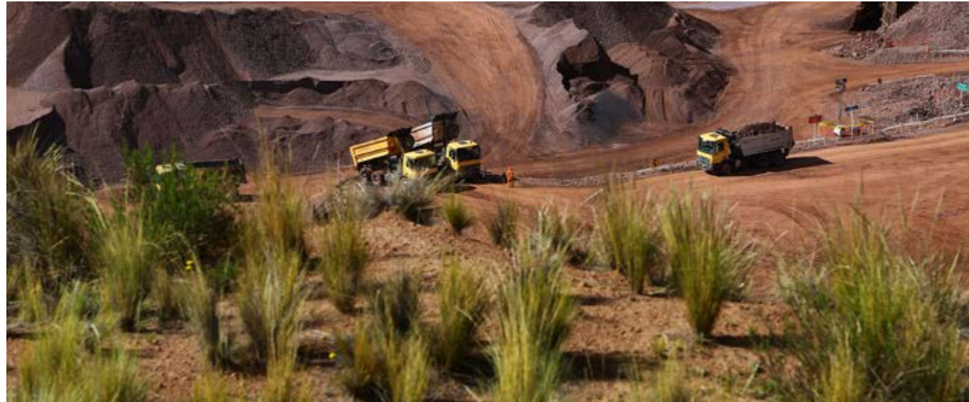
Construcción de la Segunda Calzada de la Autopista Puno - Juliaca.
