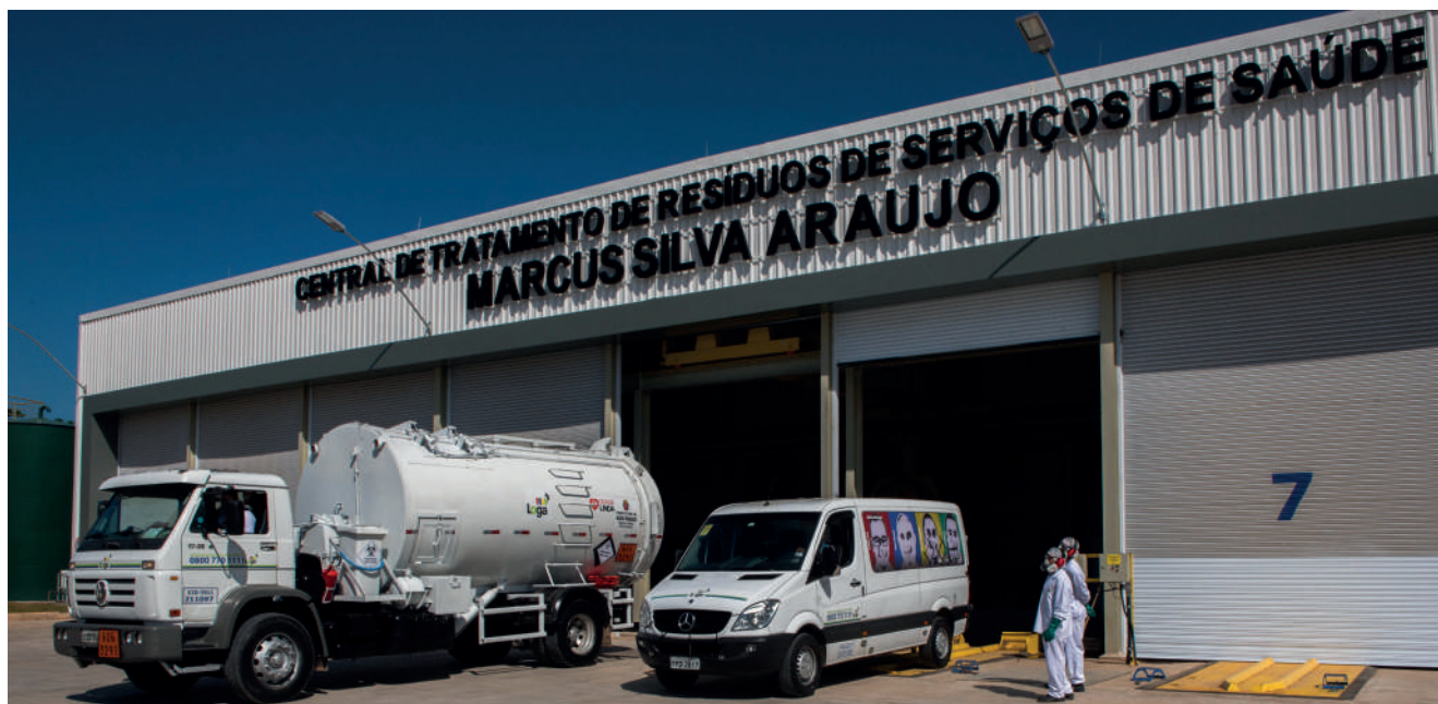
UVS LOGA - CENTRAL DE TRATAMENTO DE RESÍDUOS DE SAÚDE
