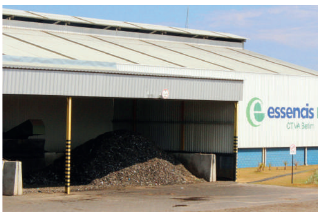
UVS ESSENCIS BETIM - UNIDADE DE VALORIZAÇÃO DE RESÍDUOS (UVE) - MG
