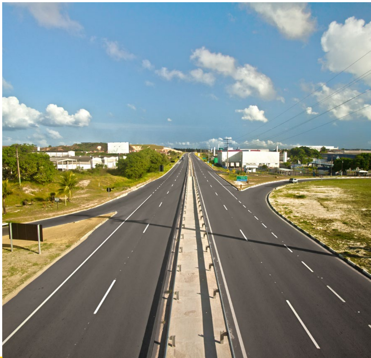
(Trecho de rodovia sob concessão da CBN)
