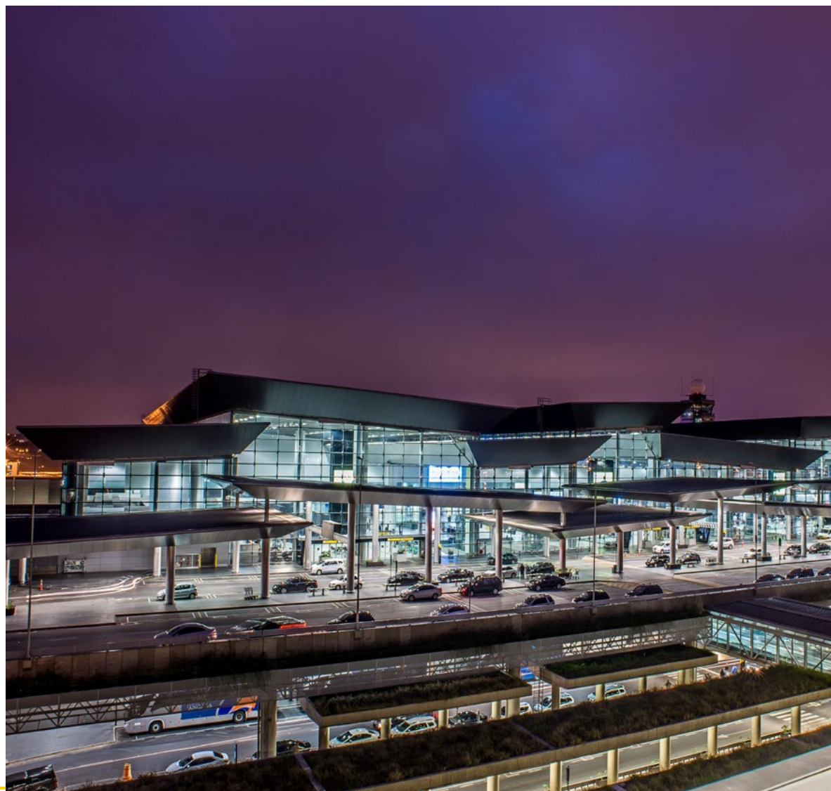
(Terminal 3 do Aeroporto Internacional de São Paulo)
