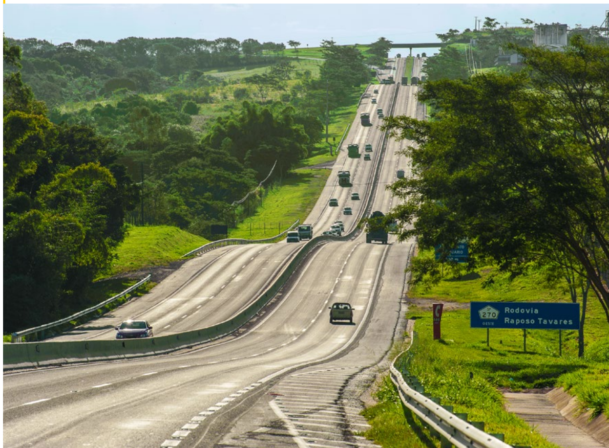
Trecho da CART no interior de São Paulo
