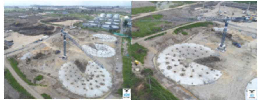
Avance de obra ampliación PTAR Salitre Fase II
