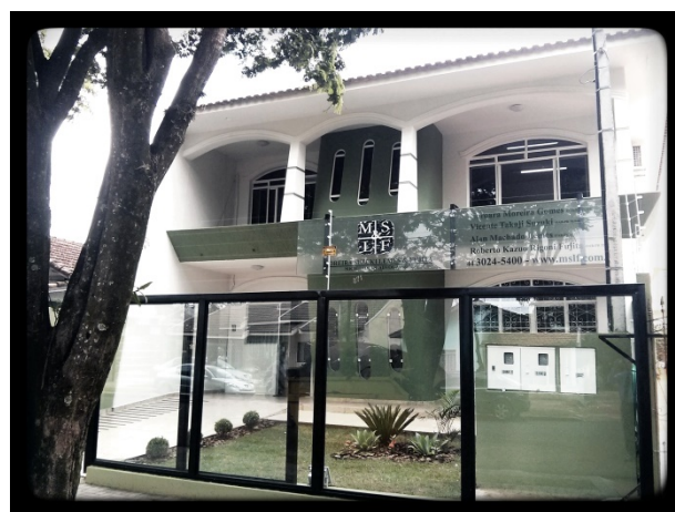
Figura 1 - Fachada da Sede da Moreira Suzuki
