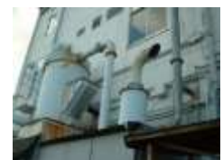
＜騒音対策の例＞ 集塵機及び大型クリーナーの排気口に消音器を設置
