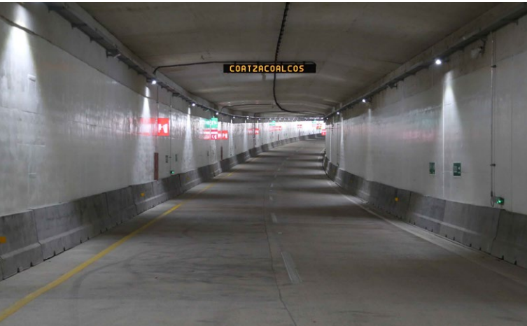
Coatzacoalcos underwater tunnel (Mexico).
