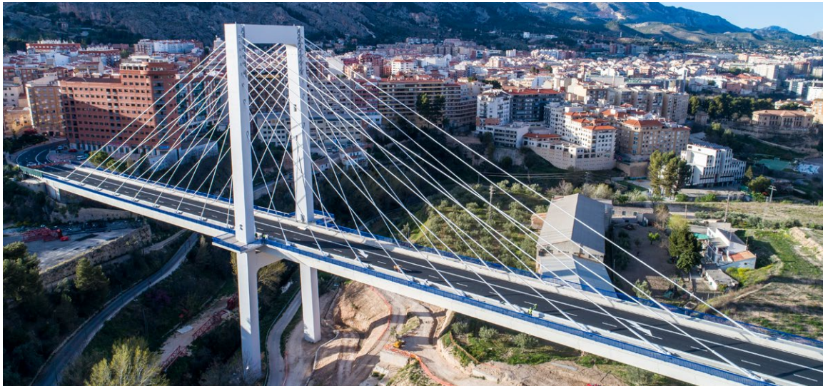
Fernando Reig Bridge (Alcoy, Alicante).
