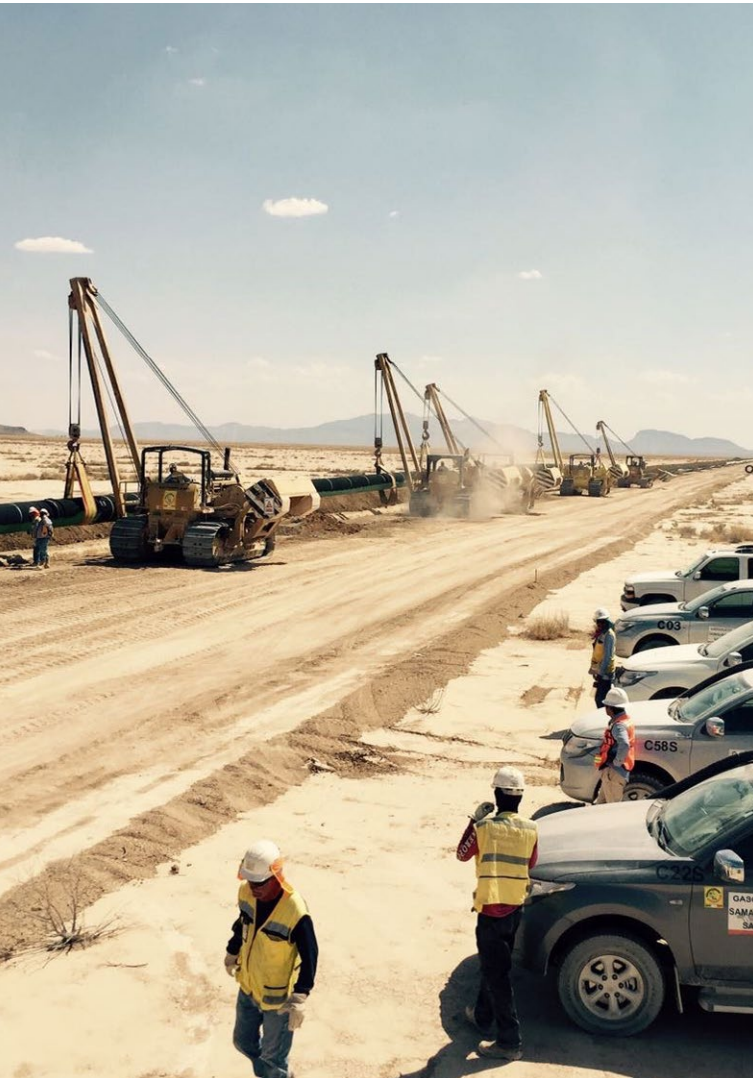
Samalayuca-Sasabe gas pipeline (Mexico).
