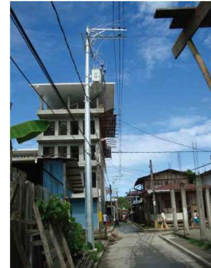
Red de MT antes (cables ACSR desnudos) y después (cables ACSR cubiertos). Resalta la utilización de las nuevas estructuras metálicas en bandera y la implementación de cables cubiertos. Olaya Herrera, Nariño.
