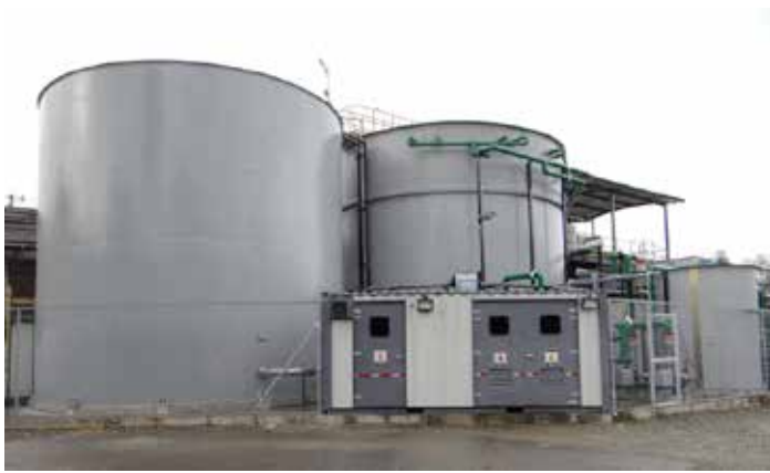
Planta de tratamiento de aguas residuales del Negocio Cárnicos.
