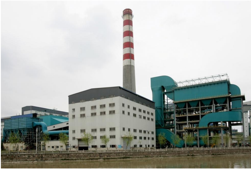
大烧结机头脱硫、除尘
