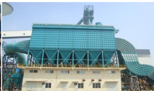
大高炉除铁场除尘
