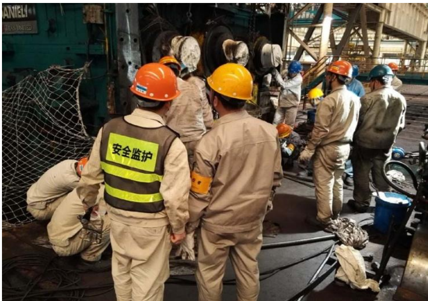
施工现场安全监护检查
