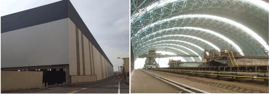
储运料场封闭项目
