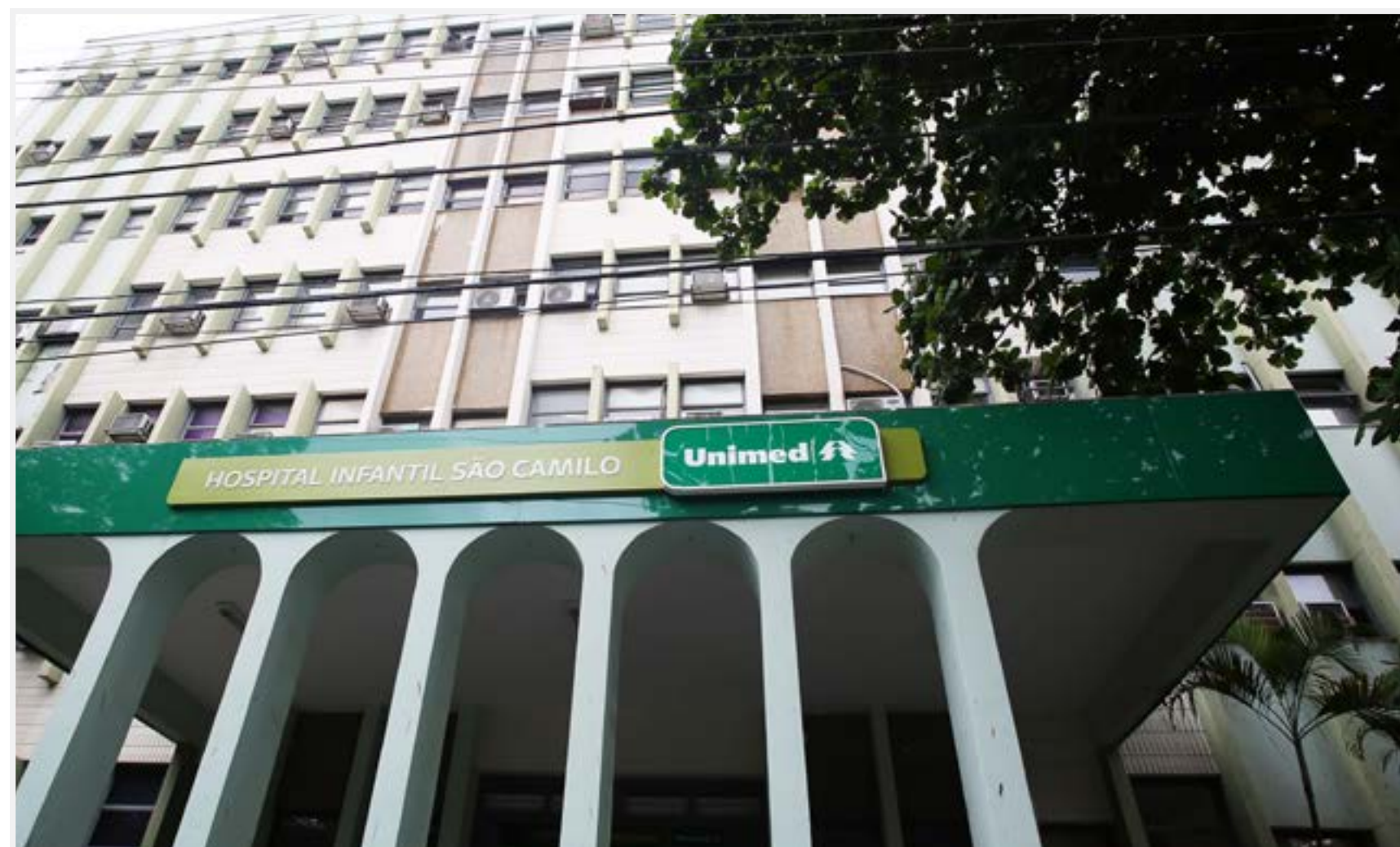
O Hospital Infantil São Camilo Unimed passou a ser gerido pela Rede Própria da Unimed-BH em 2017.
