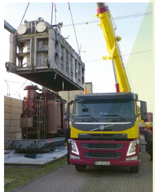
Ein ausgedienter Transformator wird umweltgerecht entsorgt.
