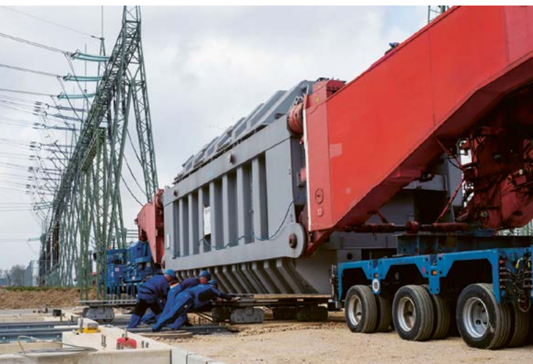
Einer der beiden Phasenschiebertransformatoren wird im Umspannwerk Röhrsdorf entladen.
