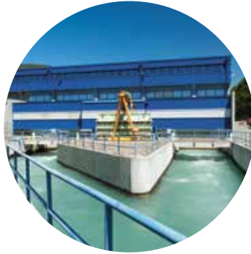
CENTRAL HIDROELÉCTRICA CHIBURGO (CENTRAL DE PASADA)
