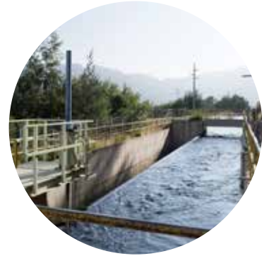
CENTRAL HIDROELÉCTRICA SAN CLEMENTE (CENTRAL DE PASADA)
