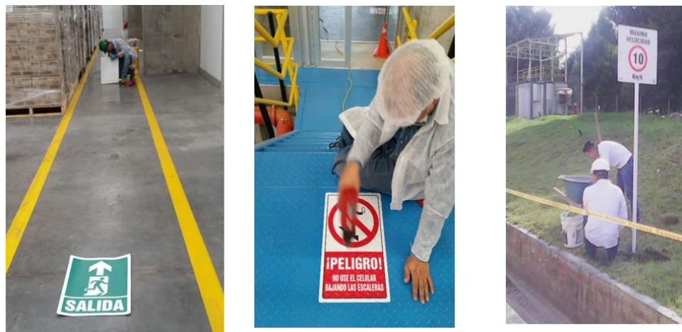
SEÑALIZACION Y DEMARCACIÓN DE AREAS
