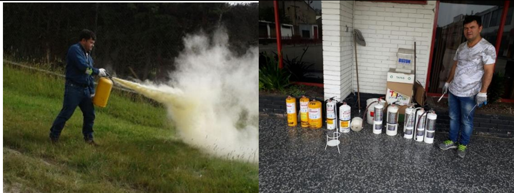
INSPECCION DE EXTINTORES
