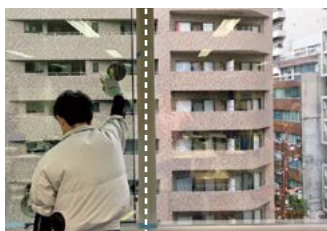
本社社屋における省エネガラス二重窓化 左側ガラス: 二重化完了 右側ガラス: 二重化前 Low-E膜をコーティング
