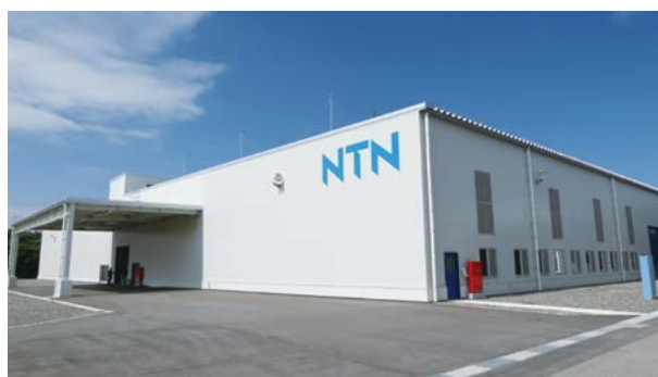
(株)NTN能登製作所 熱処理工場の外観
