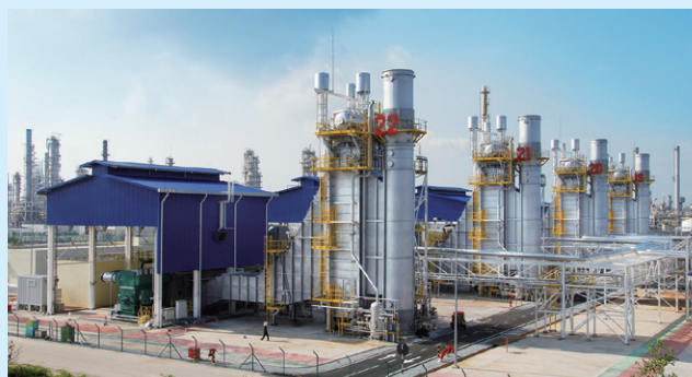
ペトロナス ペナピサン(マラッカ)コージェネレーションプラント (マレーシア)
