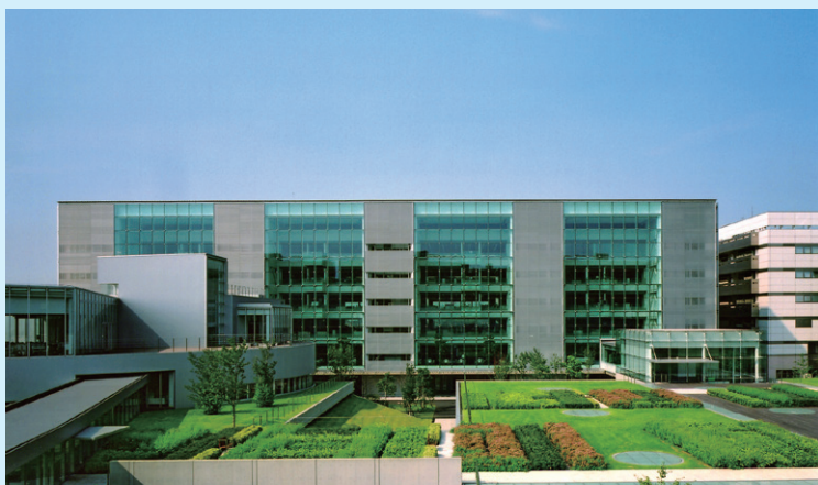
本田技研工業株式会社和光ビル (埼玉県和光市)
