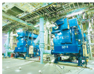
3Dレーザースキャナにより計測した点群データ
