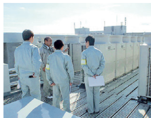
現場実習の様子
