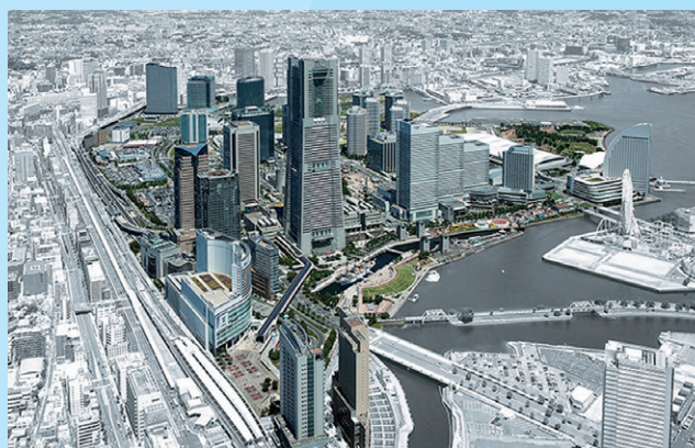
みなとみらい21中央地区・地域冷暖房 (神奈川県横浜市)
