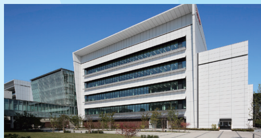
ヤクルト本社中央研究所基礎研究棟 (東京都国立市)
