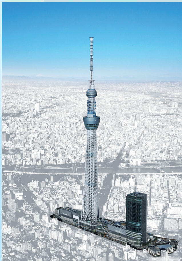
東京スカイツリー®地区・地域冷暖房 (東京都墨田区)
