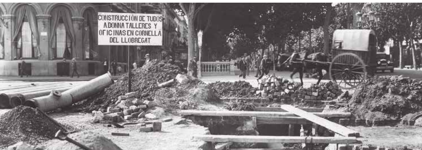
Tubería de conducción a la Plaça Catalunya, 1927
