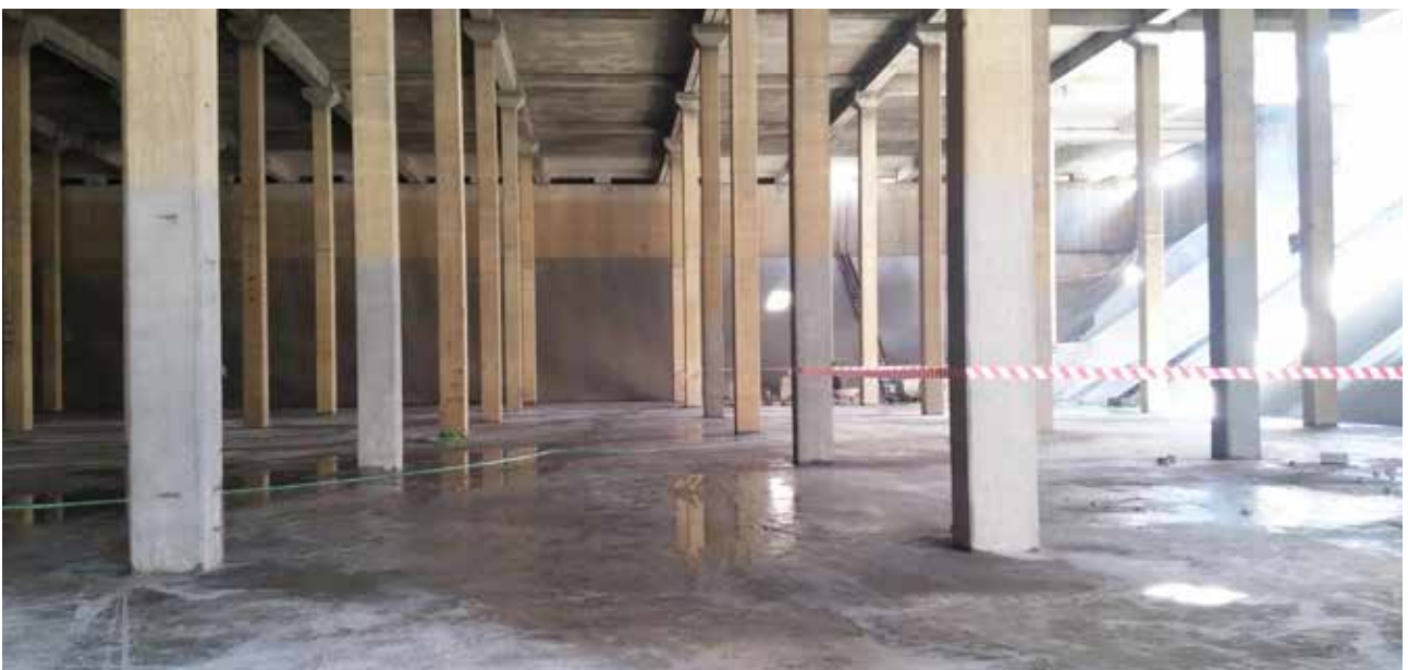
Interior del vaso del Depósito de Loaysa acondicionado
