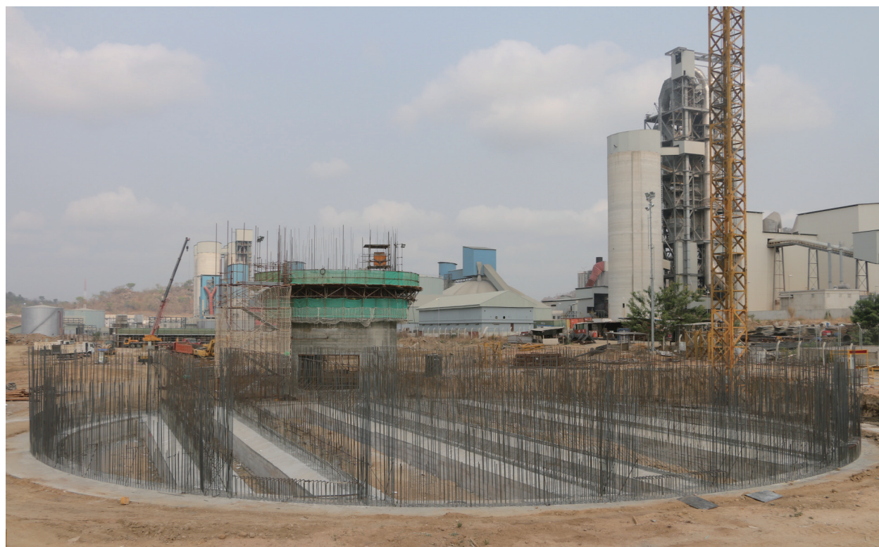
中材建设尼日利亚 EDO 2 线项目熟料及黄料库施工建设 CBMI Nigeria EDO 2 Line Project Clinker and unburned-clinker silos Construction
