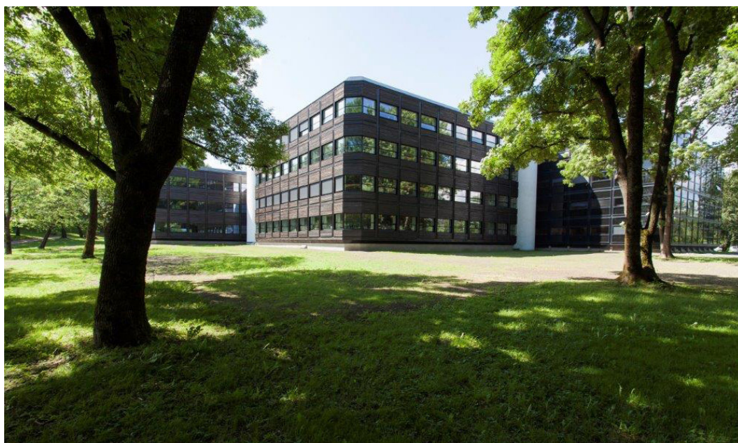
Powerhouse Kjørbo. Foto: Chris Aadland
