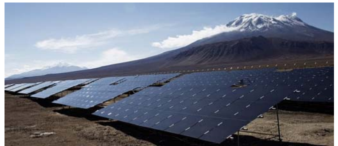
Potencia 700 Kw. / Sistema híbrido eólico – fotovoltaico con acumulador batería
