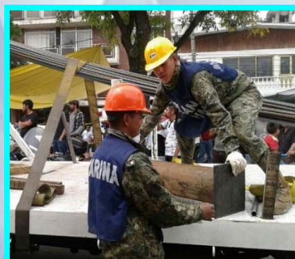
Descarga de puntales por parte de elementos de la Marina.
