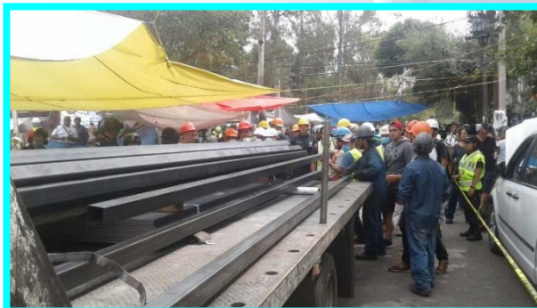
Arribo del camión con PTR.
