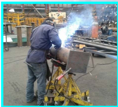
Fabricación de puntales en Nave 12 Collado Gavilán.
